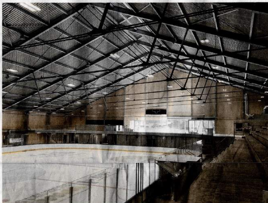
La structure porteuse et l'enveloppe de la patinoire imérienne, désormais appelée Clientis Arena, ont été totalement changées, contrairement aux gradins qui, eux, n'ont pas bougé. LBO
