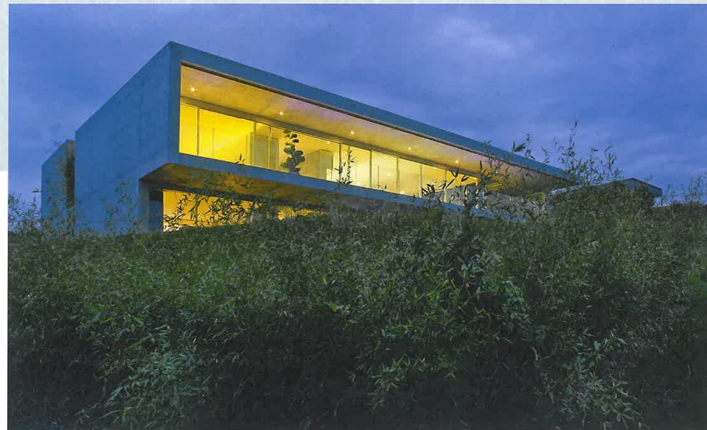
Das langgezogene Haus steht an bester ländlicher Lage über dem Bielersee. Le bâtiment en longueur bénéficie d'un emplacement idyllique surplombant le lac de Bienne.
