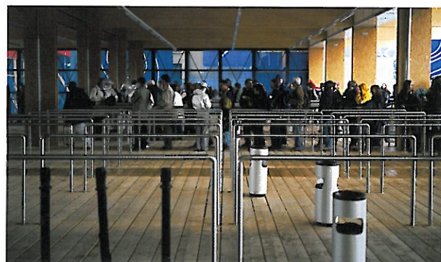
Modulare Architektur: Die Infrastrukturgebäude bestehen aus vorgefertigten Holzelementen. Die Einzelteile des Holzbausystems werden nach der Expo.02 verkauft und neu aufgebaut.
