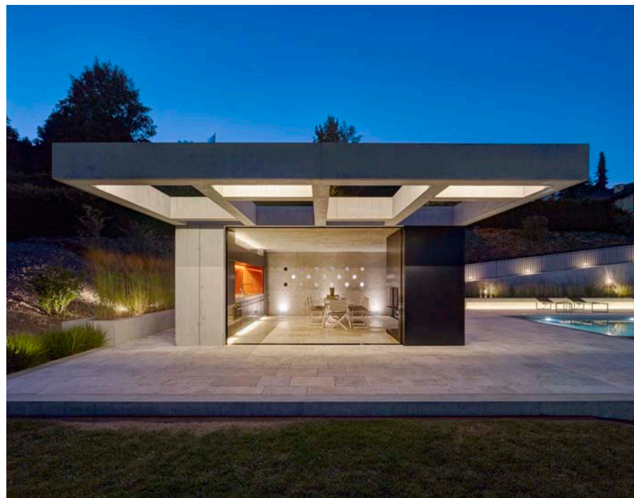
Schwebend: Das expressive Betondach scheint nur auf einer Wand, der Küchenzeile und dem Kamin aufzuliegen.
