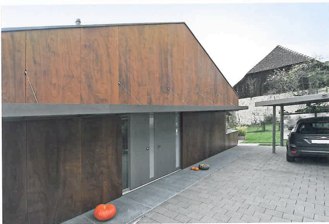
Die Fassade wurde mit hinterlüfteten Platten aus Echtholzlaminat bekleidet, hier die weitgehend geschlossene Eingangsseite.
